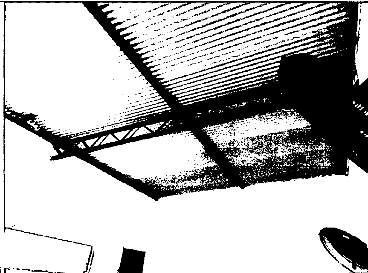
Legenda: Cobertura da sala dos congelados
